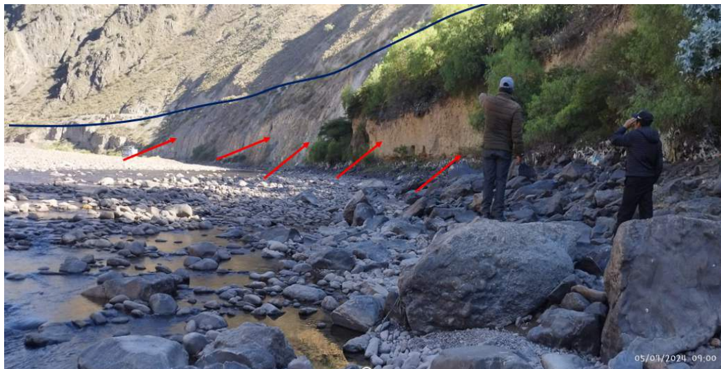
FIGURA N°03: EN LA IMAGEN SE EVIDENCIA SOCABAMIENTO DEL TALUD MARGEN IZQUIERDA A CONSECUENCIA DEL AUMENTO DEL CAUDAL DEL RIO MANTARO Y PONIENDO EN RIESGO DE DESLIZAMIENTO Y AFECTANDO LA VIA NACIONAL QUE UNE HUANCAYO A AYACUCHO.
