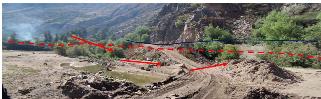
FIGURA N°04: EN EL PUNTO FINAL SE EVIDENCIA ACCESO PARA VEHICULOS PARA EL SACADO DE MATERIAL LO CUAL DIBIDO A LA FALTA DE LIMPIEZA Y DESCOLMATACION DE LOS TRABAJADORES EL RIO MANTARO SE COLMATA GENERANDO UN RIESGO HACIA LA POBLACION.
